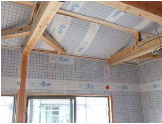
デコスドライ工法の施工状況
