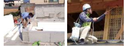
基礎断熱施工
